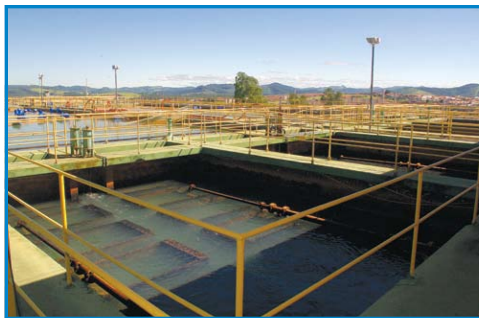
Instalações da Estação de Tratamento de Água Santa Lúcia
