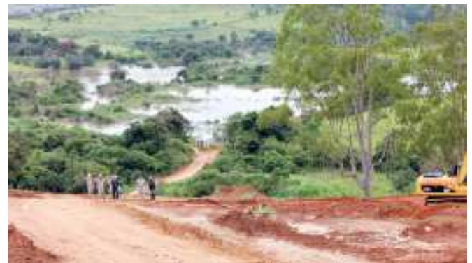
Data: 12/02/2011 - Inundação das várzeas do Rio Jaguari atrasaram as obras
