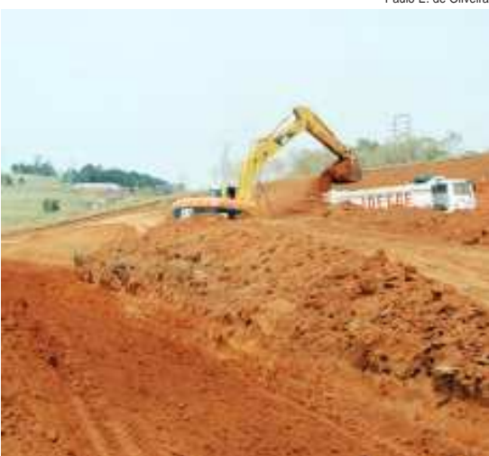
Data: 07/2010 - Grande movimentação de terra na área da futura ETE
