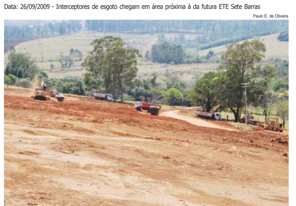
Data: 07/2010 - Terraplanagem da área onde será construída a Estação de Tratamento
