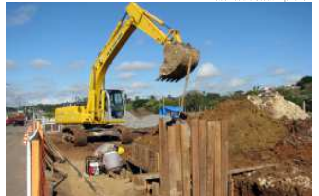
Data: 27/06/2009 - Início dos trabalhos de abertura de valas
