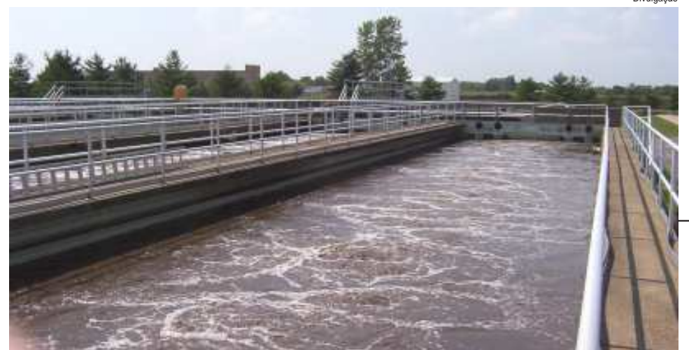
Exemplo de tanque de aeração
