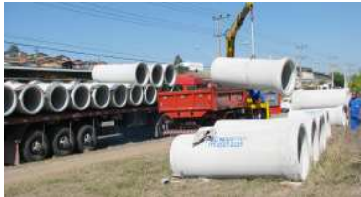
Data: 20/06/2009 - Chegada dos tubos que compõem a rede de coleta de esgoto
