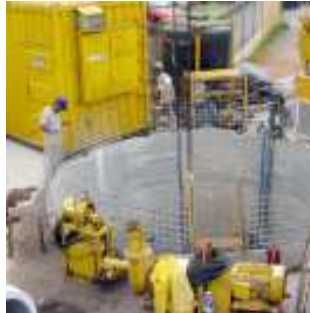
Data: 10/09/2009 - Início das trabalhos do "tatuzinho" que cria o canal para tubulação
