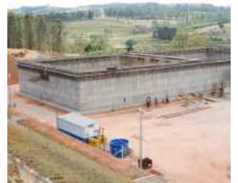
Data: 08/2011 - Obras estão em fase adiantada e a ETE começa a se tornar realidade em Bragança Paulista
