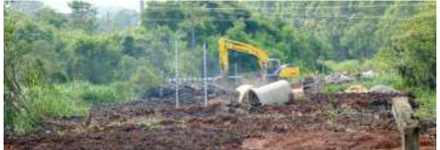
Data: 26/09/2009 - Interceptores de esgoto chegam em área próxima à da futura ETE Sete Barras
