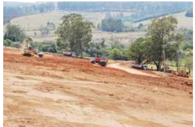
Data: 07/2010 - Terraplanagem da área onde será construída a Estação de Tratamento
